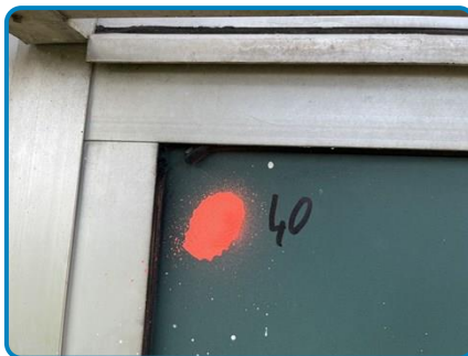
Prélèvement n° 40 : Fenêtre Jonction chassis alu et allège métal Joint noir (dans Batiment 1 MDH inoccupé RDC EXTERIEUR)
