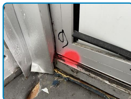
PRLV n° 9 sur Fenêtre joint Mastic
