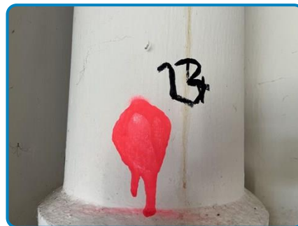
Prélèvement n° 23 : Conduit Fibre ciment (dans Batiment 1 MDH inoccupé RDC R009)
