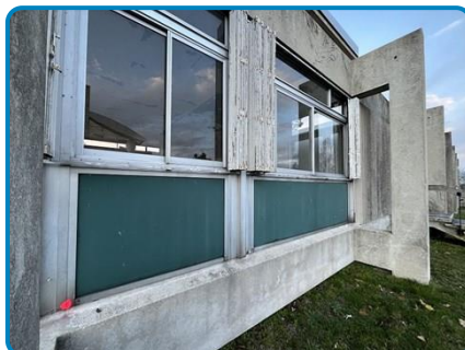
PRLV n° 29 sur Fenêtre Métal Joint mastic
