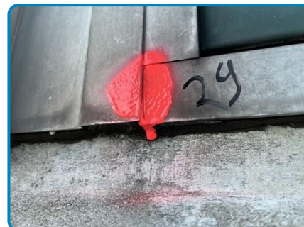
PRLV n° 29 sur Fenêtre Métal Joint mastic
